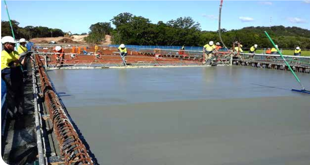
First deck pour on southern land section
