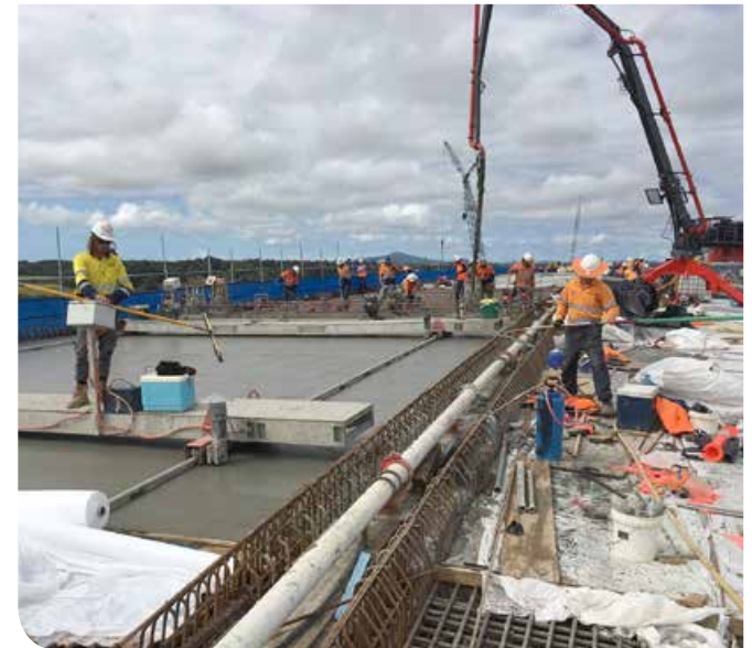
Last span concrete deck pour to marine spans
